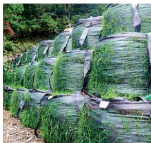
施工後約1ヶ月半
