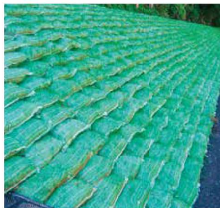
土留グリーンバッグ工
