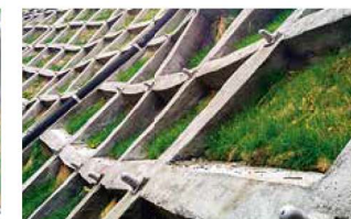
施工後5ヶ月半
