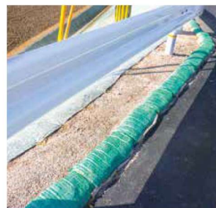
法肩まくらグリーンバッグ工
