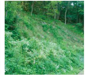
施工後1年4ヶ月
