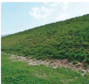
施工後1年2ヶ月
