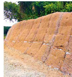
施工後(ひし形金網併用)
