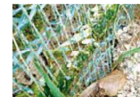
施工後1年5ヶ月
