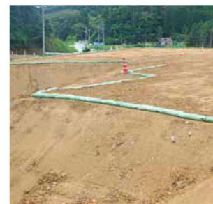
法肩まくらグリーンバッグ工
