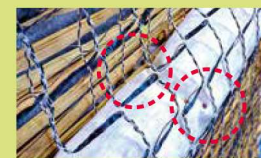
捕捉基材袋が小段を形成し、種子を捕捉。
