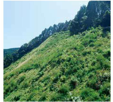
施工後1年6ヶ月
