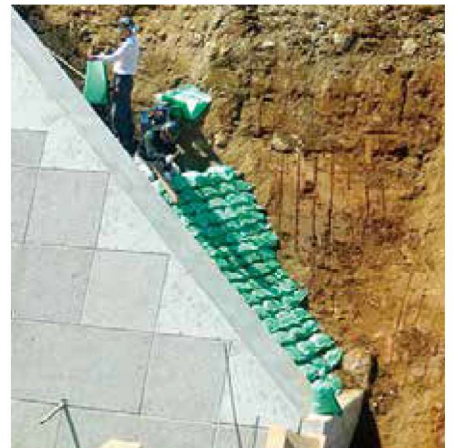
擁壁裏の土砂流出防止
