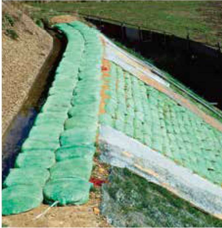
法面崩壊部分の埋戻し
