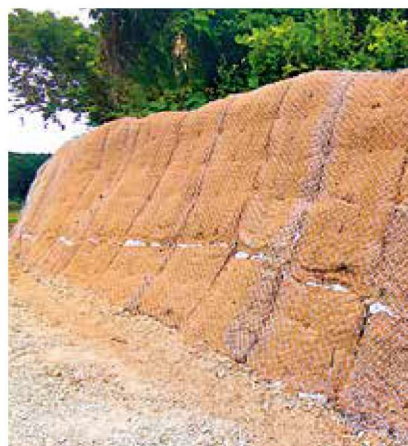
施工後(ひし形金網併用)
