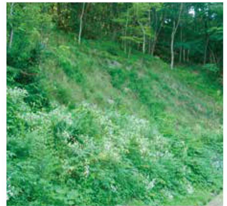
施工後1年4ヶ月
