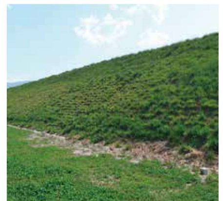
施工後1年2ヶ月
