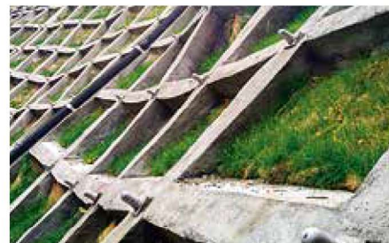
施工後5ヶ月半
