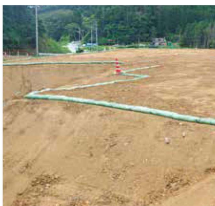
法肩まくらグリーンバッグ工
