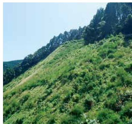
施工後1年6ヶ月
