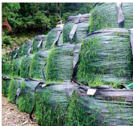
施工後約1ヶ月半
