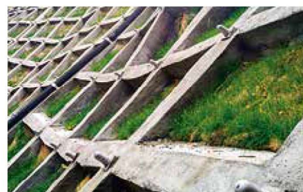
施工後5ヶ月半
