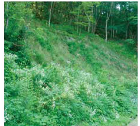
施工後1年4ヶ月
