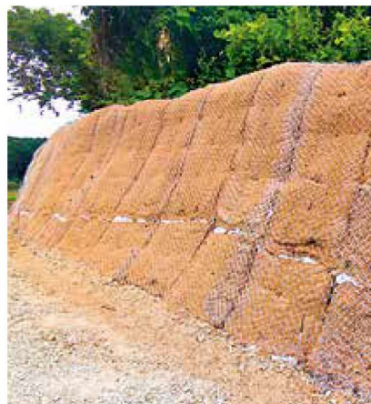
施工後(ひし形金網併用)
